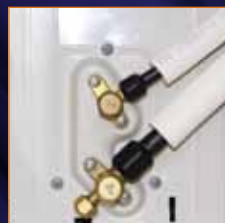
7. Fertigstellung des Anschlusses
