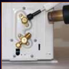
6. Wärmebehandlung der Isolierhülse
