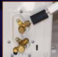
5. Installation der Standard-Schraubverbindung (Anzugs-Drehmoment gem. Bedienungsanleitung Klimagerät)
