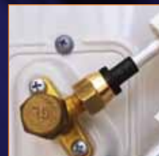
5. Installation der TALOS® DUAL Schraubverbindung (Anzugs-Drehmoment gem. Bedienungsanleitung Klimagerät)
