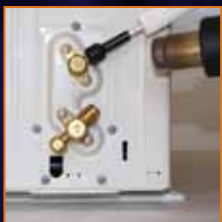
6. Θέρμανση με φλόγιτρο ή πιστόλι θερμού αέρα
