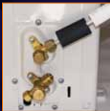
5. Σύνδεση περικοχλίου (ροπή σύσφιξης βάσει εγχειρίδιου κατασκευαστή)
