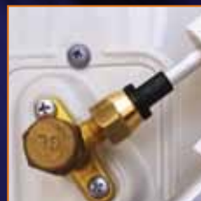
5. Σύνδεση περικοχλίου (ροπή σύσφιξης βάσει εγχειρίδιου κατασκευαστή)
