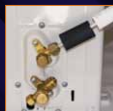
5. Instalación de la tuerca de latón estándar (según el manual de instrucciones del fabricante del equipo de A/C)
