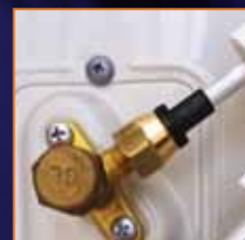
5. Instalación de la tuerca especial TALOS DUAL (según el manual de instrucciones del fabricante del equipo de A/C).
